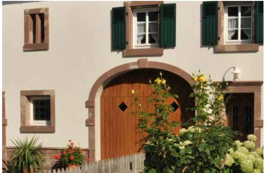
Sanierung und gestalterische Aufwertung der Leerstände zur besseren Vermarktung (Beispielfoto)
