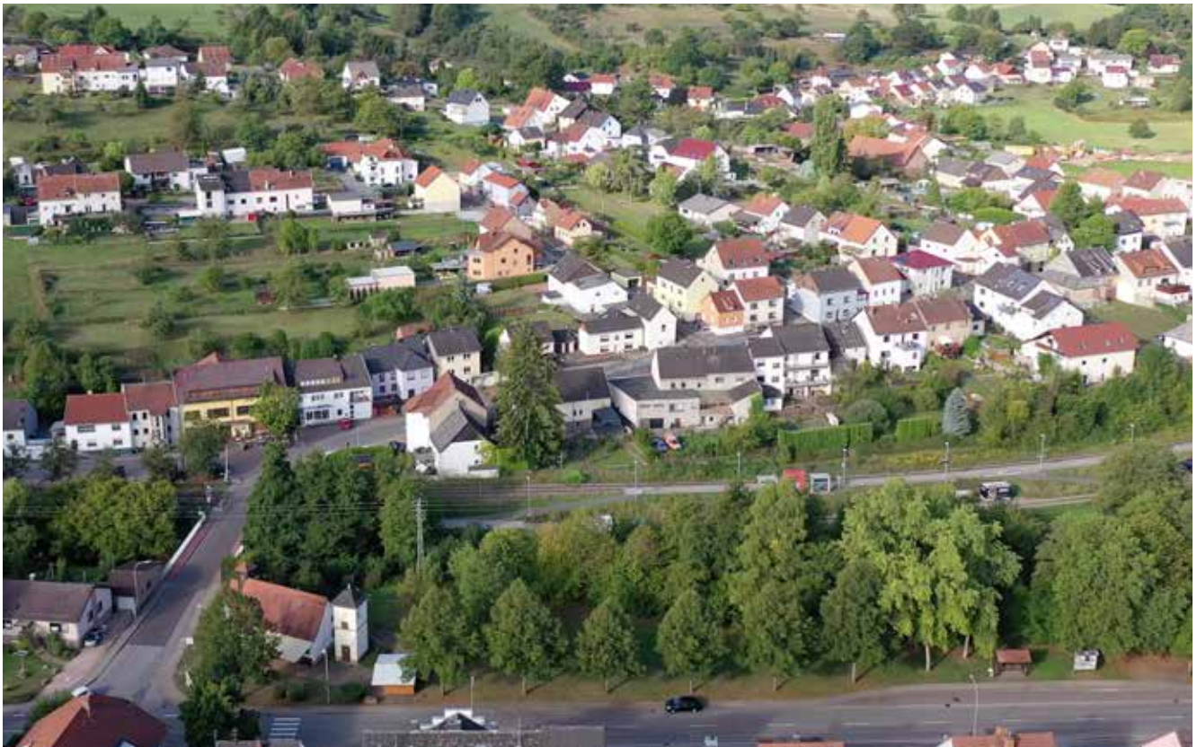
Zerschneidungseffekte in Wustweiler - Ortsdurchfahrt und Bahnlinie
