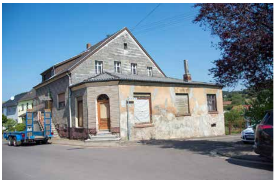
Leer stehendes Wohngebäude mit ehem. Einzelhandel im Bereich Fußgängerbrücke (Bahnhofstraße)
