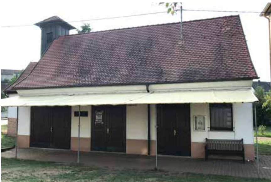
Kelterhaus des Obst- und Gartenbauvereins in der Lebacher Straße mit Gestaltungspotenzial
