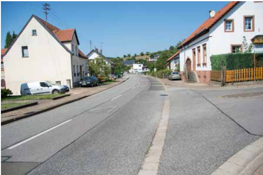
Unzureichend gegliederte Ortsdurchfahrt „Lebacher Straße/ Illinger Straße“
