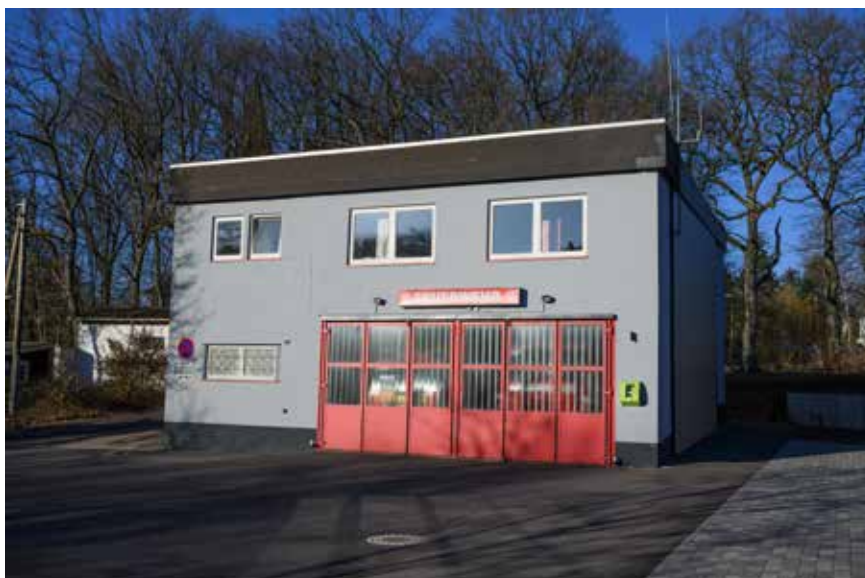
Feuerwehrgerätehaus am Verzy-Platz
