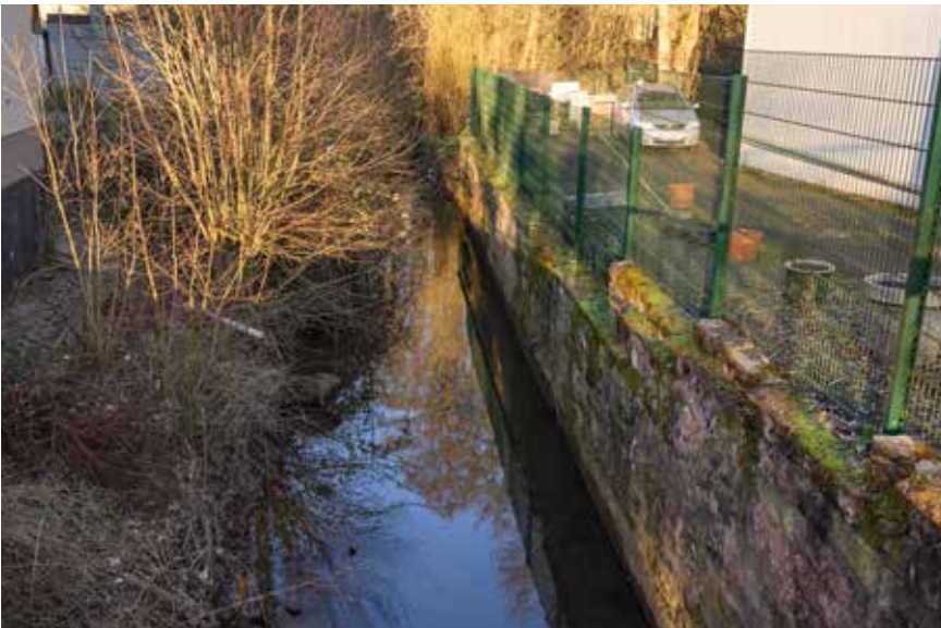
Verlauf der Ill nördlich der Ortsdurchfahrt „Neunkircher Straße“ (L 295)
